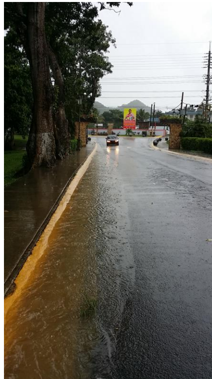
Imagen 60: Entrada del Barrio Río Lajas comenzando a inundarse
