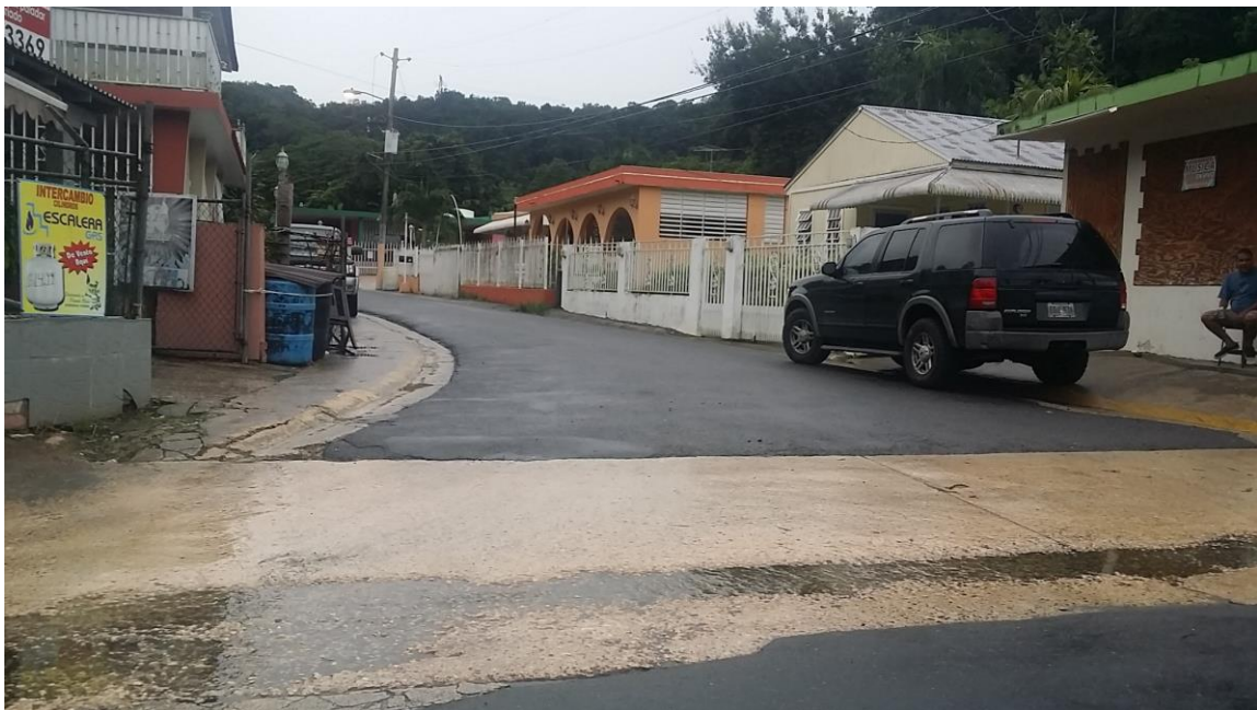
Imagen 61: Entrada de cemento donde resbalan vehículos
