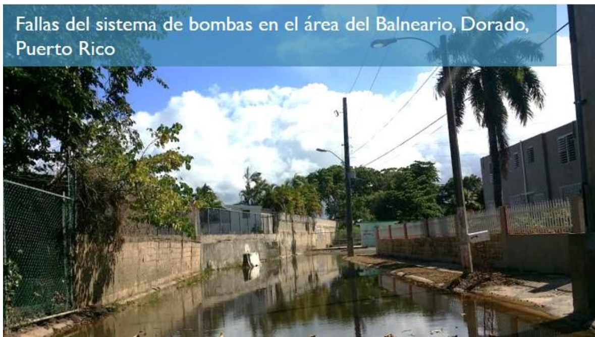
Imagen 48: Sistema de bombas para drenaje en el área del Balneario
