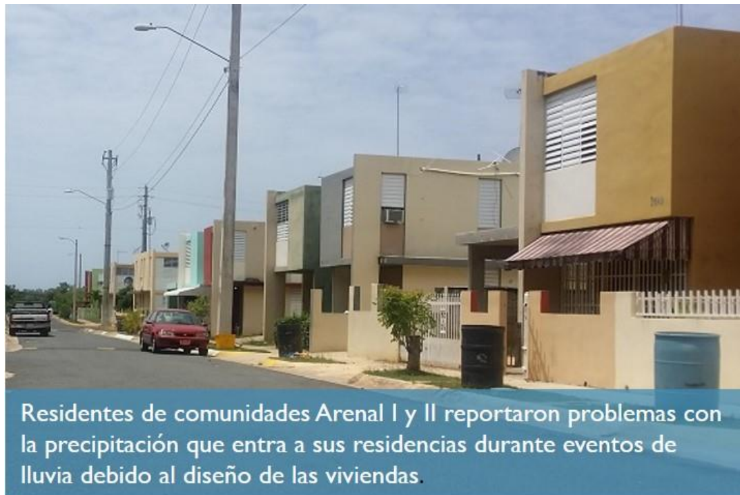
Imagen 37: Comunidades Arenal I y II reportan problemas estructurales en las viviendas
